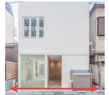
間口の狭い狭小地での施工
