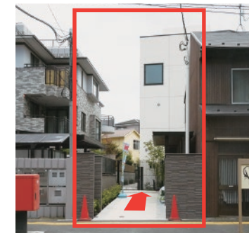
道路から奥まった旗竿地での施工
