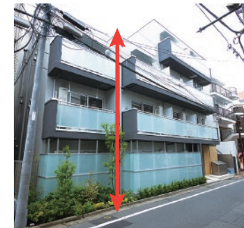
住宅地での低層マンション施工
